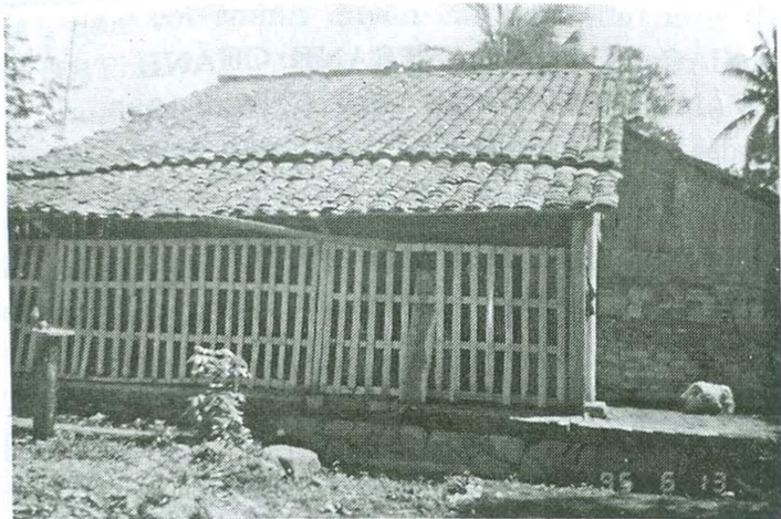
Nhà ông Cả Nhì Ngưu, xóm Gò Cà, Tổ 3, ấp Hòa Lợi, xã Hòa An. Nơi thành lập Chi bộ Đảng đầu tiên xã Hòa An, (đầu năm 1930) và đóng trụ sở ở vườn xoài phía sau nhà.
