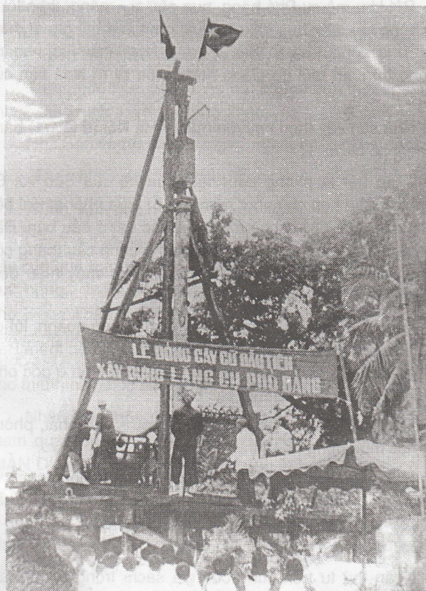
- Lễ đóng cây cừ đầu tiên khởi công xây dựng phần mộ cụ Phố bắng (22-08-1975)
