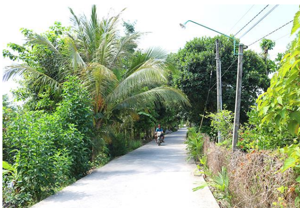
Tuyến đường đan rạch Cán Cờ ấp Long Hưng 1 được xây dựng giúp người dân đi lại thuận lợi
