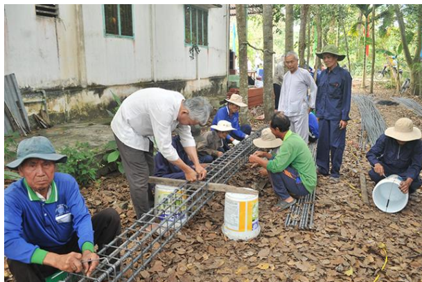
Các thành viên Đội thi công cầu, đường huyện Lai Vung xây dựng hàng trăm cây cầu bê-tông
